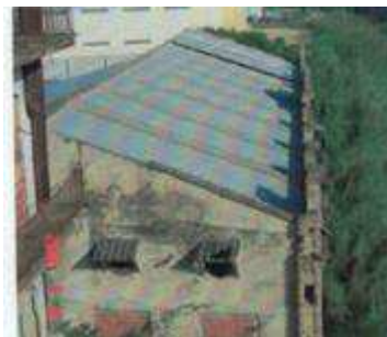
Reconstrucción cubierta fibrocemento
