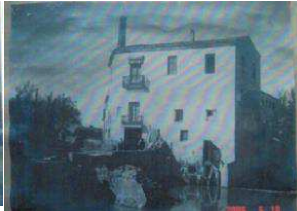
Ampliacion de una planta
