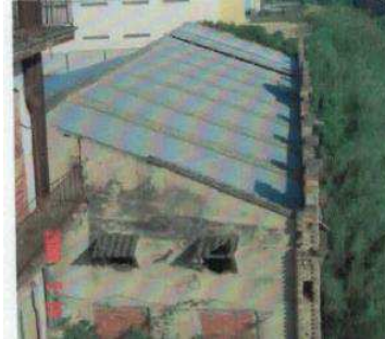
Reconstrucción cubierta fibrocemento
