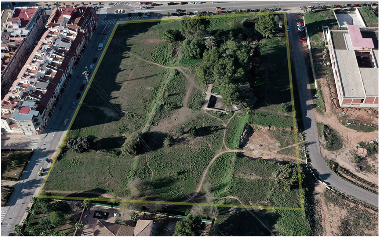
Vista aérea 01 (este)
