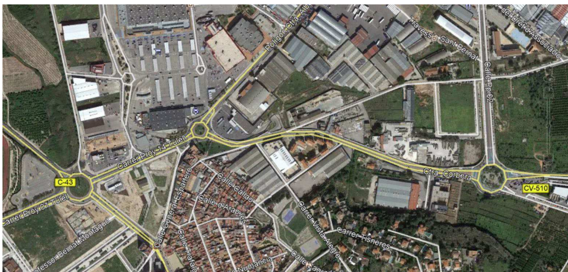
Imagen general del ámbito principal de la simulación realizada, entre las carreteras CV-43, CV-505 y CV-510.
