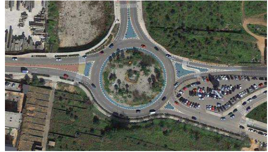
Figura 44. De Arriba a Abajo. Glorieta CV-43/ Partida de Tulell; Glorieta Partida de Tulell/CV-505; Glorieta CV-510 de acceso al hospital.
