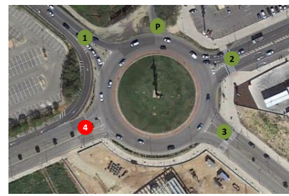
Glorieta que intercepta la CV-43 con la zona de Tulell
