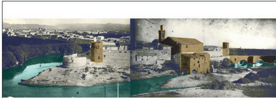
FOTOGRAFÍA HISTÓRICA FRENTE OESTE DE LA VILA
