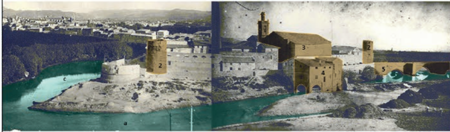
FOTOGRAFÍA HISTÓRICA FRENTE OESTE DE LA VILA
