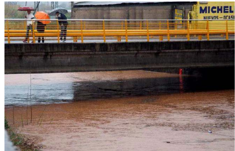
Vista del nivel del Bco. de la Casella con las lluvias de marzo de 2015
