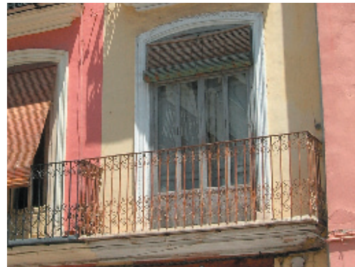
2-3-4. Fenestración, carpintería y rejería de hierro pintado.
