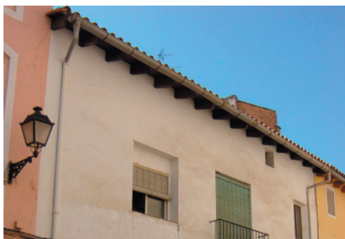
1. Alero. 6. revoco continuo 7. Canalón de acero galvanizado.
