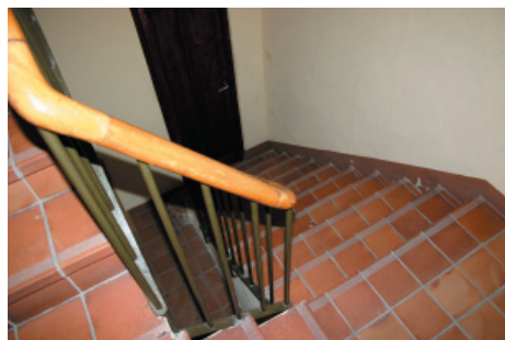
11. Escalera de doble tramo
