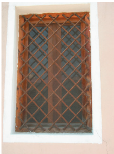
2-3-4. Fenestración y carpintería. Rejería de hierro pintado.
