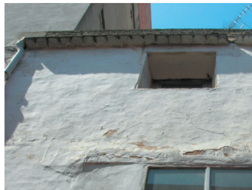
1-5. Alero y canalón
