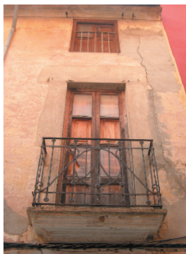
2-3-4. Fenestración y carpintería. Rejería de hierro pintado.
