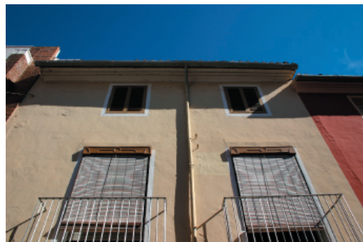
1-6. Alero y canalón de acero galvanizado.
