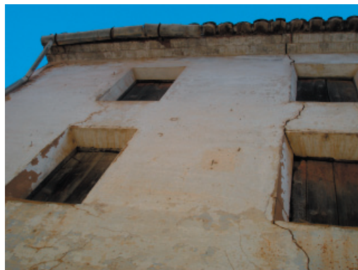
1-6. Alero y canalón de acero galvanizado.
