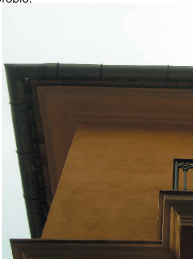
1-9. Alero tipo 4. Canalón y bajante de acero galvanizado.
