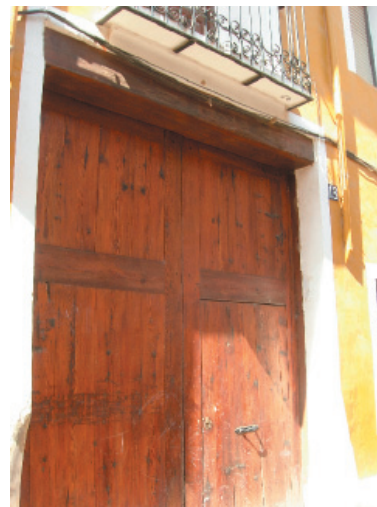
3-7. Carpintería de madera. Dintel de madera.
