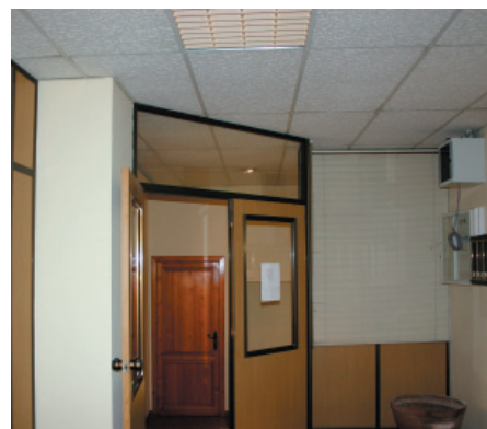
15. Falsos techos desmontables 16. Tabiques desmontables
