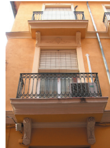
4-5-11. Carpintería de aluminio. Persianas de plástico. Aire acondicionado en fachadas.
