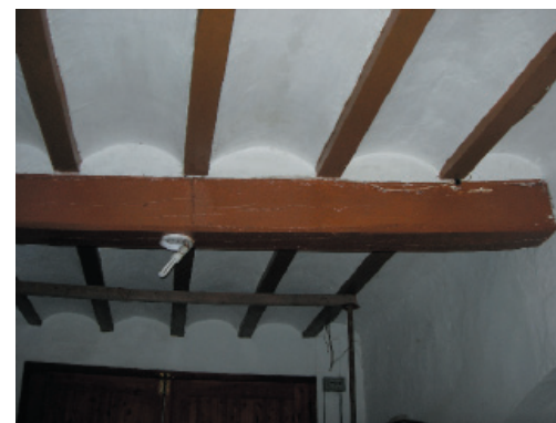
9. Vigas y viguetas de madera.
