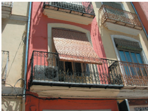
2-3-4. Fenestración y carpintería. Rejería de hierro pintado.
