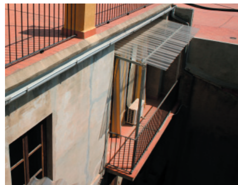
18. Cubrición de policarbonato
