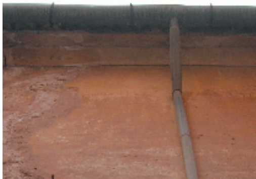
1-5-6. Alero y canalón de acero galvanizado. Revoco continuo pintado.
