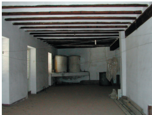
16. Vigas y viguetas de madera
