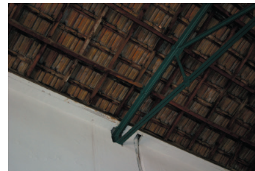
6. Celosías estructurales de fundición.
