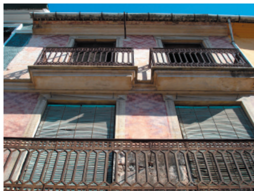
1-7. Alero y canalón de acero galvanizado.
