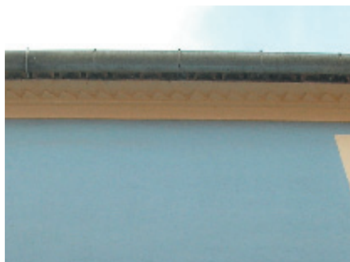
1-6. Alero y canalón de acero galvanizado.
