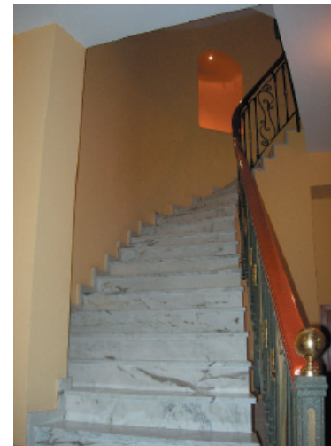
9-10. Escalera de dos tramos, uno recto y el otro con terminación circular.Revestida de marmol, con barandilla de forja y pasamanos de madera.
