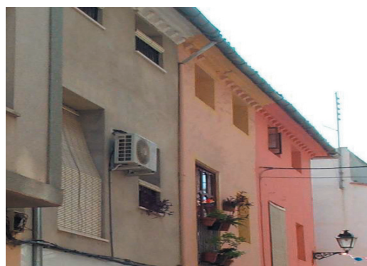
2. Composición vertical 4. Revoco continuo y pintado
