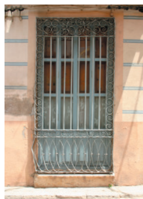
6-10. Rejería de forja. Alfeizar de piedra.
