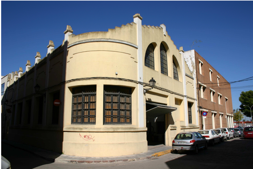
M6/13. Tipología de edificación industrial. Nuevo elemento protegido por el Catálogo de Bienes y Espacios Protegidos d'Alzira.
