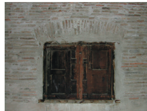
15. Carpintería de madera (ventana de la cambra al patio)
