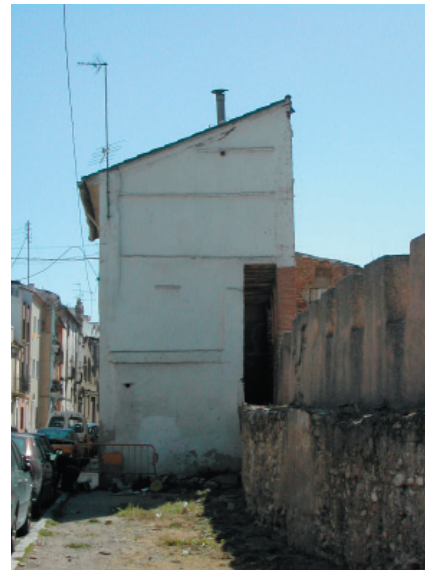
Muralla Parque Arabia Saudí (Zona Sur) Casa adosada a la Muralla.
