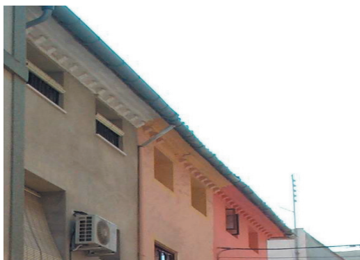
1. Alero 5. Canalón de acero galvanizado
