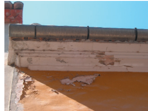
1-6. Alero y canalón de acero galvanizado.
