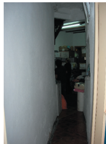
Vista del interior del local comercial situado en planta baja.
