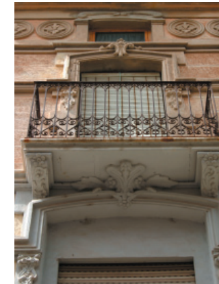
2. Composición vertical . 3. Recercado de los huecos de fachada principal de piedra.
