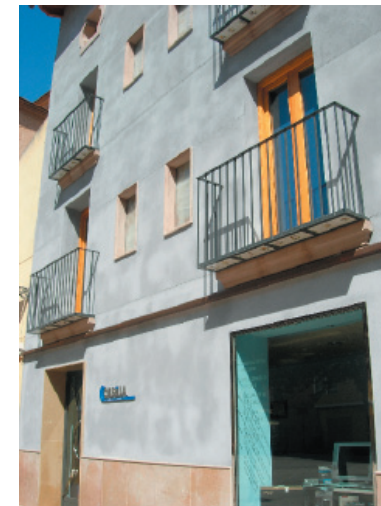
2-3-5. Fenestración y carpintería. Mortero monocapa.
