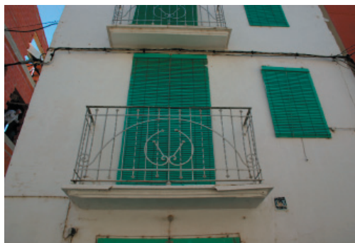
2-3-4. Fenestración, carpintería y rejería de hierro pintado.
