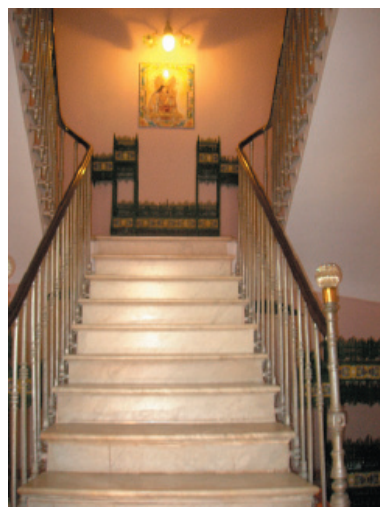
11-12. Escalera tabicada a montacaballo. Revestida de marmol.
