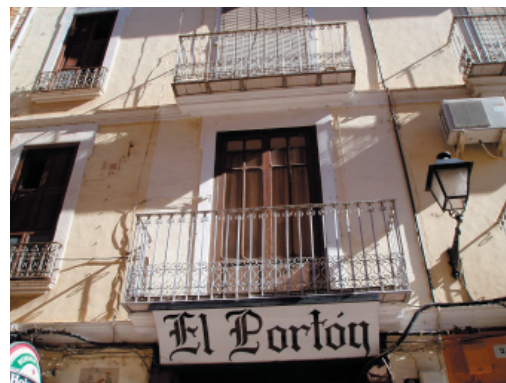
2-3-4. Fenestración y carpintería. Rejería de hierro pintado.
