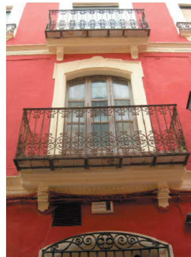
9. Rejerías de forja
