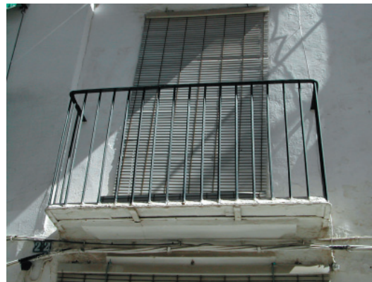
2-3 Fenestración y carpintería 4. Rejería de hierro pintado
