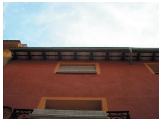
1-6. Alero. Canalón y bajantes de acera galvanizado.
