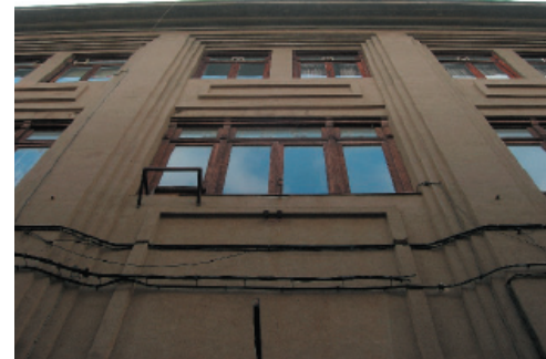
1-2-5. Alero y fenestración. Revoco continuo pintado.
