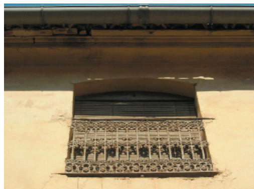
1.Alero de ladrillo cerámico recto y canalón.
