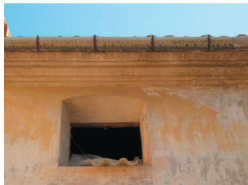
1-6. Alero y canalón de acero galvanizado.
