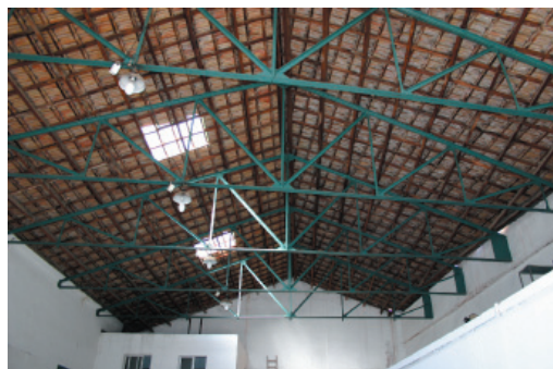
6. Celosías estructurales de fundición.
