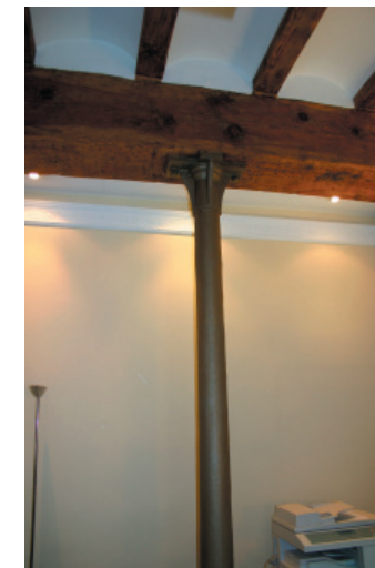
10. Pilares de fundición
