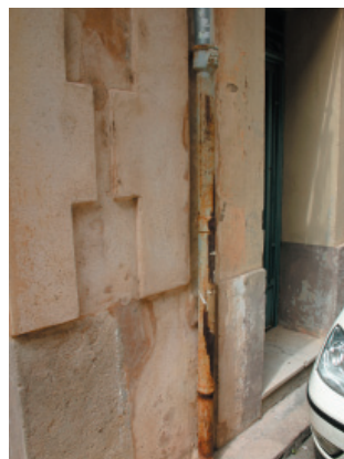
9. Último tramo de bajante de fundición.
