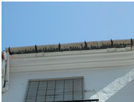
1-6. Alero y canalón.
