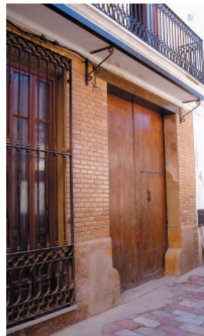
4. Rejería de forja 3. Puerta de madera
