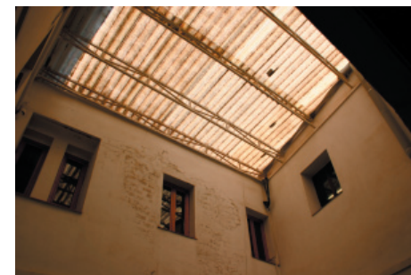
14. Cubrición del patio. Vista interior
