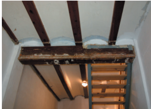
16. Forjados de vigas y viguetas de madera
