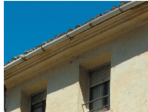
1-6. Alero y canalón de acero galvanizado.
