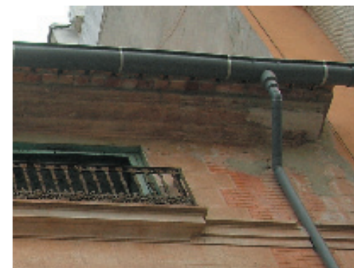
6. Canalón y bajantes de PVC.
