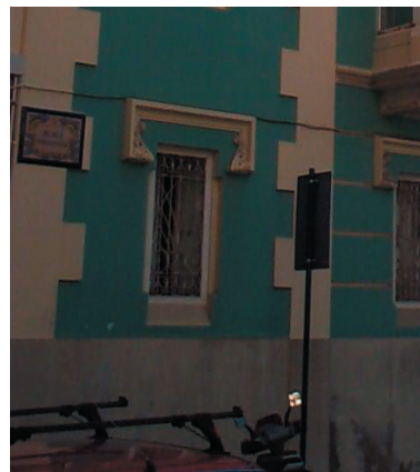
5. Rejerías de forja en los huecos de la planta baja.
