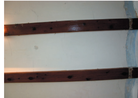
16. Forjados de vigas y viguetas de madera.
