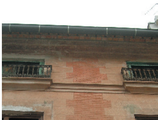
1-5. Alero y revestimiento de ladrillo caravista.
