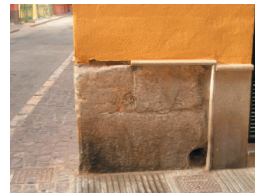
8-10. Zócalo de piedra. Guardacantó de piedra.
