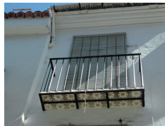
5. Revoco continuo. 6. Canalón acero galvanizado. 7. Sotabalcó.
