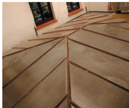
14. Cubrición del patio
