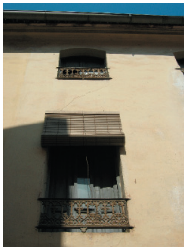
2-5. Fenestración y Revoco.
