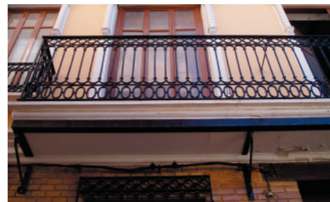
3. Carpintería de madera 4. Rejería de forja
