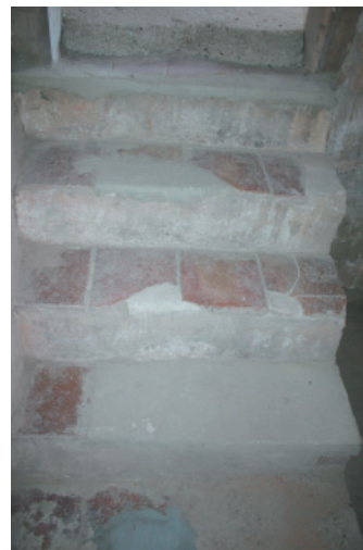
14. Escalera en la cambra de ladrillo macizo y baldosas cerámicas.
