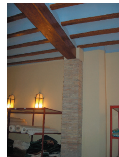
8. Vigas y viguetas de madera vistas.
