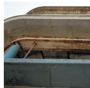
8. Pilares de fundición.
