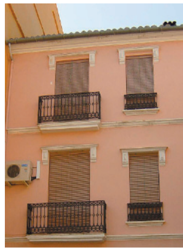
4- 6. Carpintería de madera. Rejería de forja
