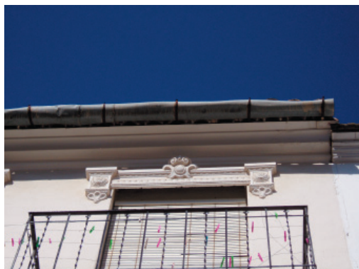
1. Alero 6. Canalón de acero galvanizado
