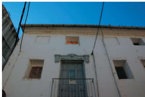
1-6. Alero y canalón de acero galvanizado.
