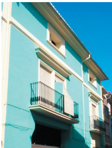
1-10. Alero tipo 4. Imposta que separa los huecos apaisados
