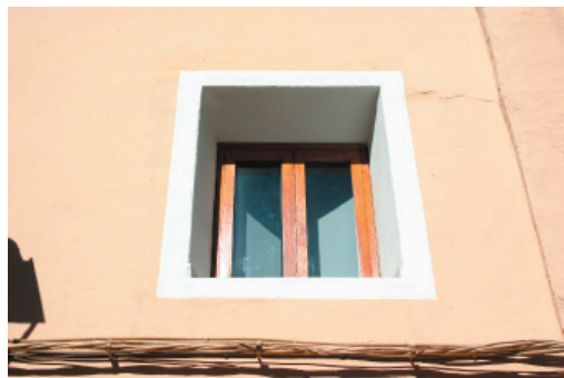
2-3. Fenestración y carpintería de madera.
