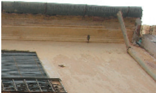
1-6. Alero y canalón de acero galvanizado.
