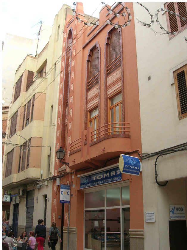
M41/08. Tipología de edificación racionalista. Nuevo elemento protegido por el Catálogo de Bienes y Espacios Protegidos d'Alzira.
