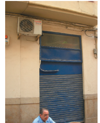
5. Extractor de aire acondicionado.
