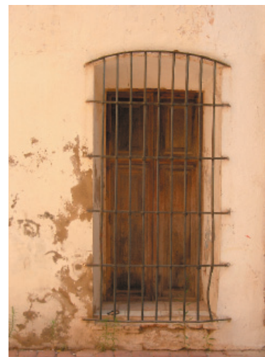
2-3-4. Fenestración y carpintería. Rejería de hierro pintado.
