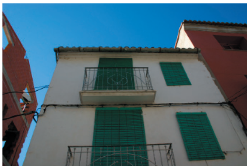
1-5-6. Alero, revoco continuo pintado y canalón de acero galvanizado.
