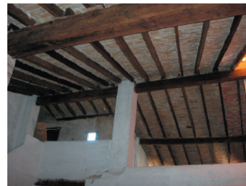
9. Vigas y viguetas de madera.
