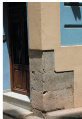
10. Remate en esquina de piedra.
