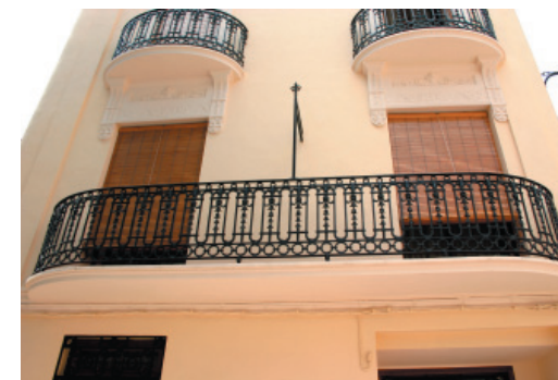
2-4-14. Composición vertical con correspondencia en huecos. Carpinterías de madera y con persianas de madera. Balcón corrido en la primera planta.
