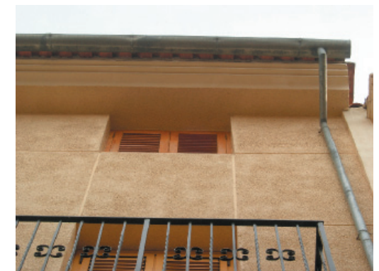
11. Canalón y bajantes de acero galvanizado.
