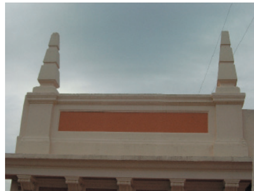
9. Remates de fachada, con antepecho de fábrica de ladrillo y pináculos situados en los ejes extremos de la torre.
