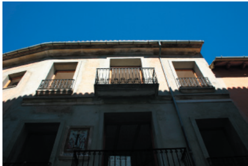
1-6. Alero y canalón de acero galvanizado.
