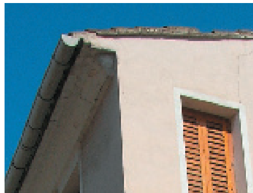
1-6. Alero y canalón de acero galvanizado.
