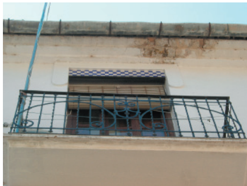
1-5-6. Alero, revoco continuo pintado y canalón de acero galvanizado.
