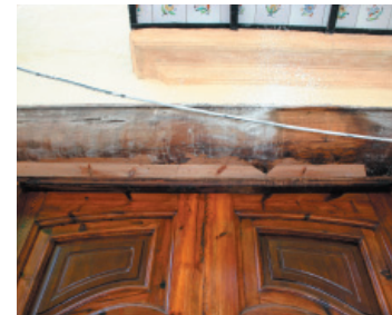
9. Dintel de madera en la puerta de entrada.
