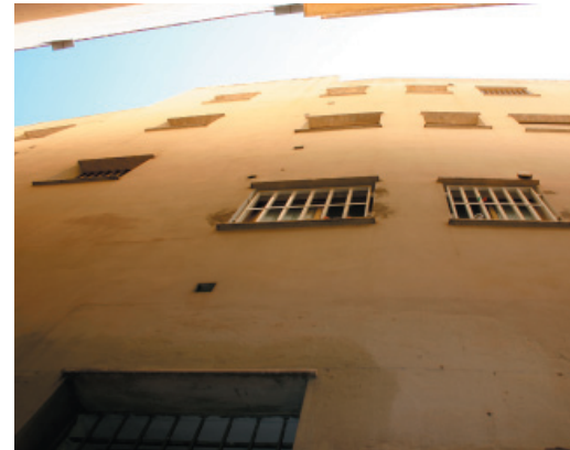
3-5. Apertura de huecos aleatoria en fachada post. Carpinterías de aluminio.
