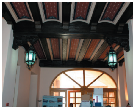
15. Viguetas de madera con revoltón
