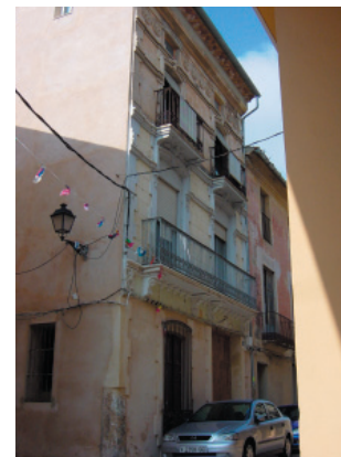
2. Composición vertical . 3. Recercado de los huecos de fachada principal de piedra.
