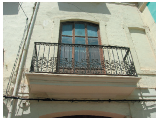
2-3-4. Fenestración, carpintería y rejería de hierro pintado.
