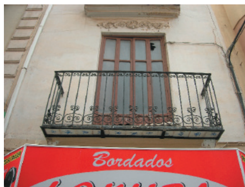
2-3. Fenestración y carpintería de madera. 4-7. Rejería y sotabalcó de azulejo cerámico.
