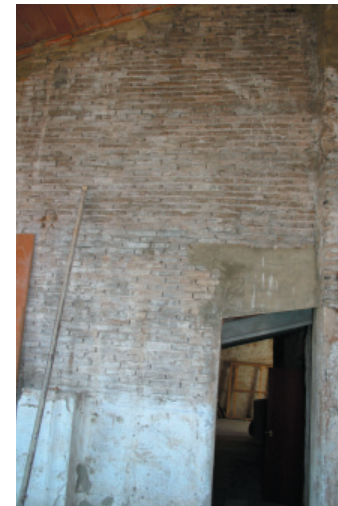
15. Muros y pilares de ladrillo macizo.
