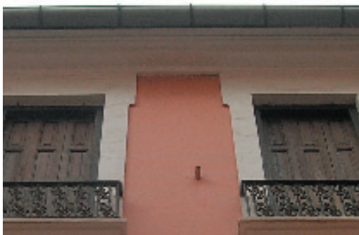
1-3. Alero y carpintería de madera.
