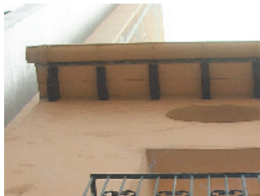
1-6. Alero y canalón de acero galvanizado.
