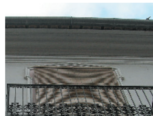
1-4-6. Alero y canalón de acero galvanizado. Rejería de hierro pintado.
