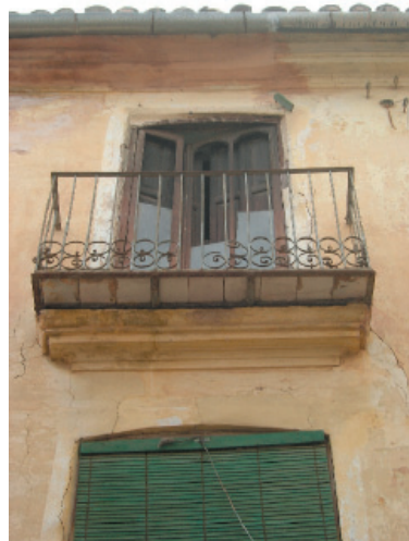
2-3. Fenestración y carpintería. 4-5. Rejería de hierro pintado, revoco continuo pintado.
