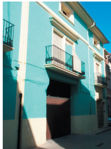
4-5-7-9. Carpintería de aluminio. Persianas de plástico. Cables de instalaciones.
