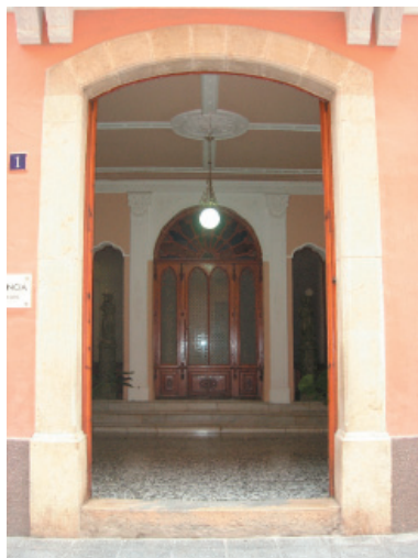
5-10. Carpintería de madera. Umbral y jambas de piedra.
