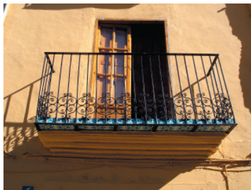
2-3-5-8. Fenestración, carpintería, rejería y sotabalcó cerámico.
