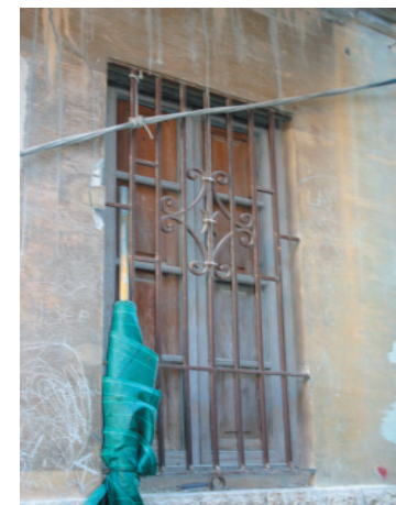
2-3. Carpinterías de madera. Rejerías de forja.
