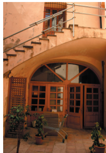
10. Escalera patio, tabicada a montacaballo.
