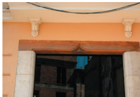
9-10. Dintel de madera. Jambas de piedra.
