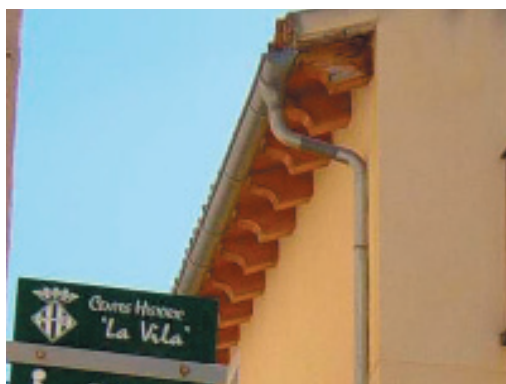
1-6. Alero y canalón de acero galvanizado.
