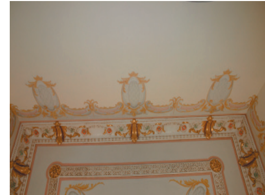
13. Interior: Molduras pintadas
