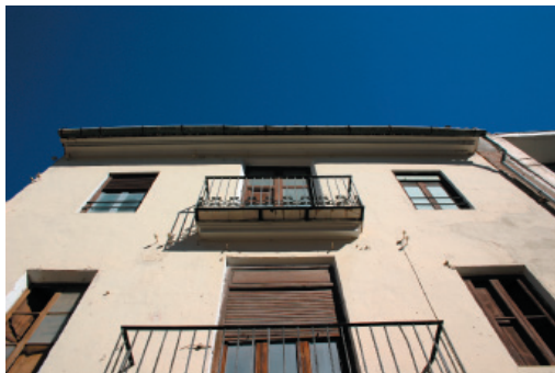
1-6. Alero y canalón de acero galvanizado.
