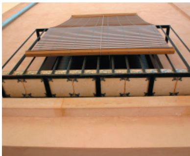
5. Rejerías de forja 11. Sotabalcón de baldosas cerámicas pintadas.
