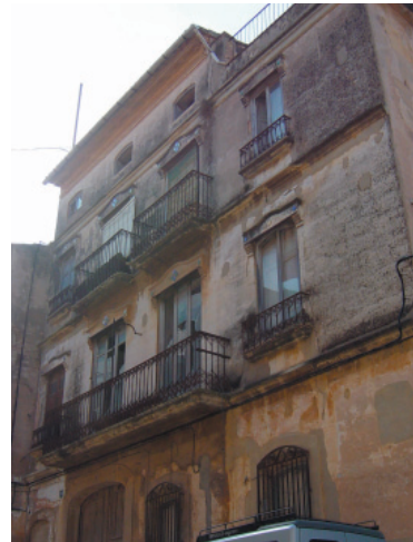
4-5. Simetría y verticalidad en huecos de la fachada. Recercado de huecos. 7-9. Rejerías de forja. Balcón corrido en la primera planta.
