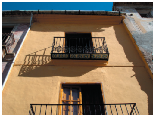
1-6-7. Alero, revestimiento y canalón de acero galvanizado.
