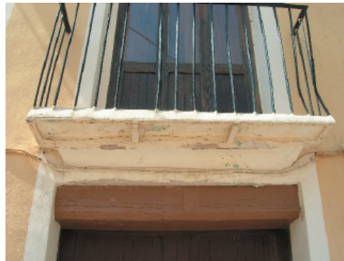
4-7. Rejería de hierro pintado. Dintel de madera.
