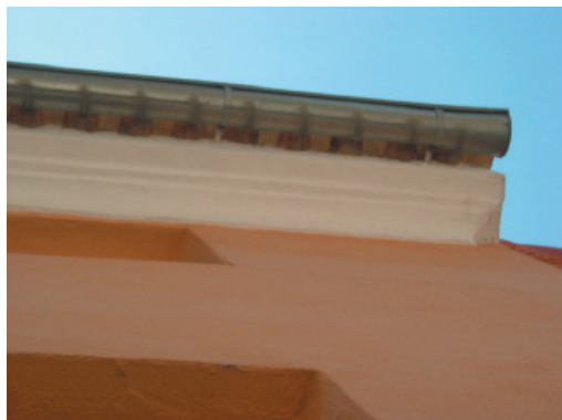
1-6. Alero y canalón de acero galvanizado
