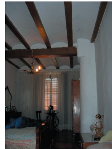
8. Vigas y viguetas de madera.
