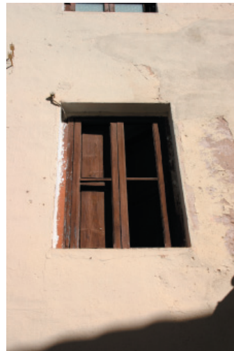
2-3-5. Fenestración, carpintería. revoco continuo pintado.
