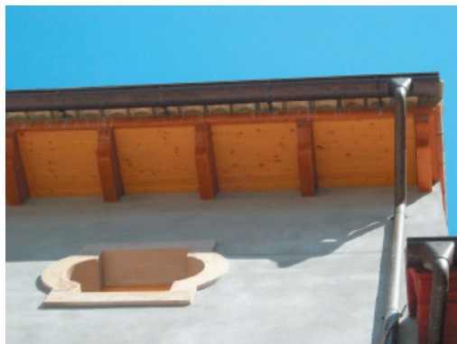
1-6. Alero y canalón de acero galvanizado.
