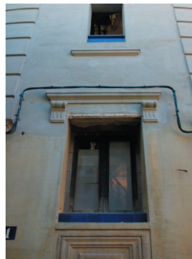
1. Recercado de huecos en la esquina del edificio.
