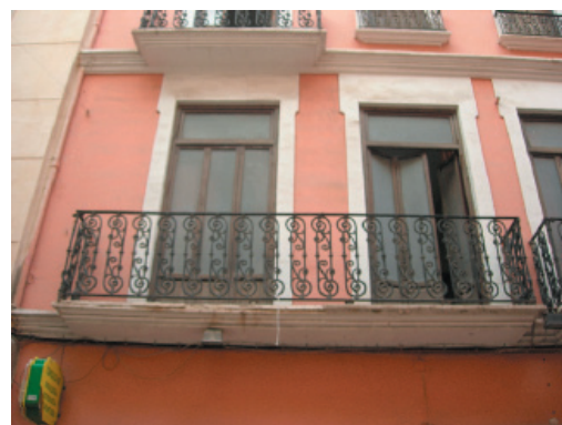
2-4-5. Fenestración, rejería de hierro pintado. Revoco continuo pintado.
