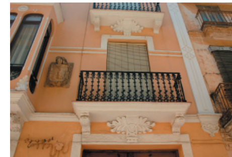
2-5. Recercado en huecos. Rejerías de forja.
