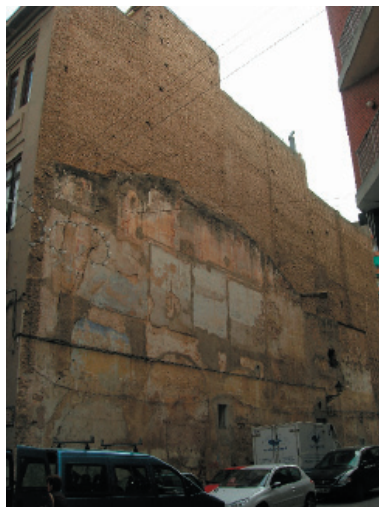
Fachada C/ Costa.
