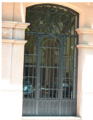
4-5. Rejerías de forja. Zócalo de piedra.
