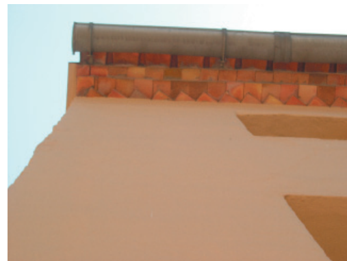
1-6. Alero y canalón.
