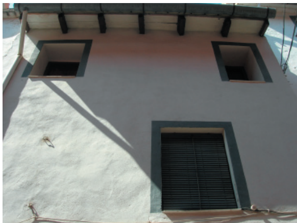
1-5. Alero y canalón de acero galvanizado. 2-3. Fenestración y carpintería de madera.
