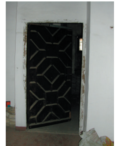
15. Carpintería de madera (puerta de subida a la cambra)
