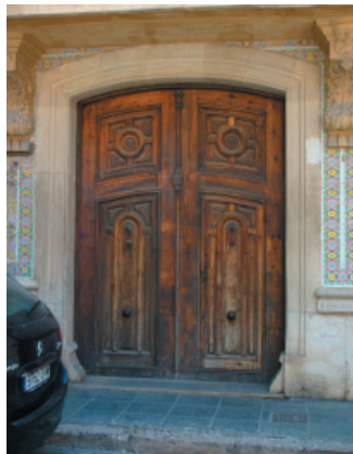
4-8. Carpinterías de madera. Zócalo de piedra.
