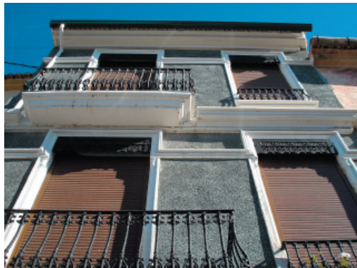
1-6. Alero y canalón de acero galvanizado.
