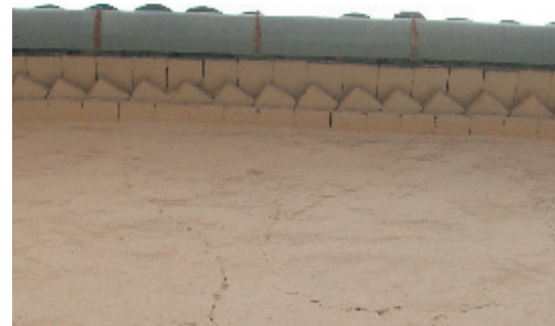
1-6. Alero y canalón de acero galvanizado.
