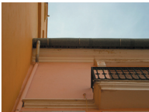
1-8. Alero. Canalón y bajante de acero galvanizado.
