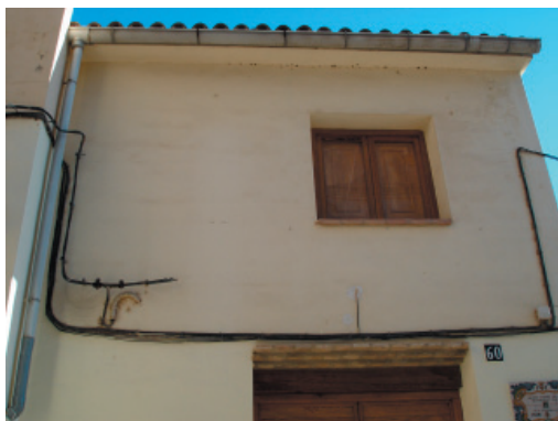
1-5. Alero y canalón de acero galvanizado.
