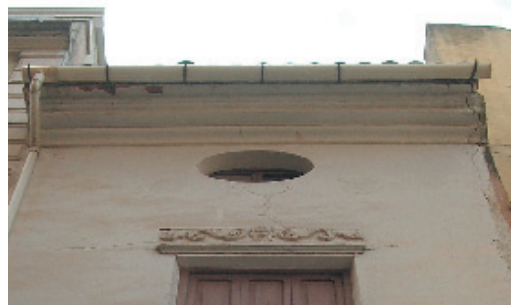
1-5-6. Alero y revoco continuo pintado. Canalón y bajantes de acero galvanizado.
