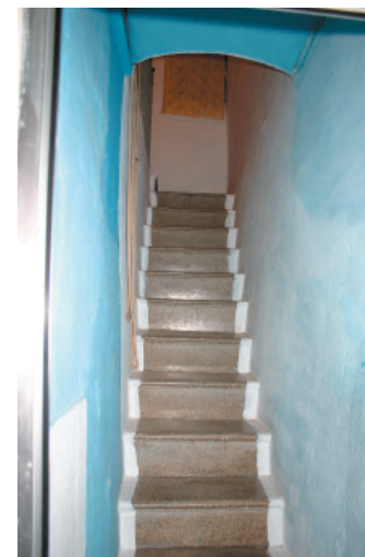
7-8. Escalera tabicada a montacaballo y solado de piedra.
