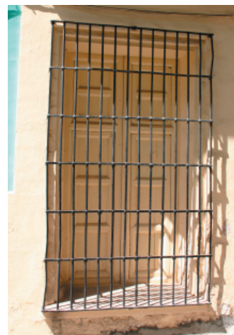
3-6. Carpinterías de madera. Rejerías de forja.
