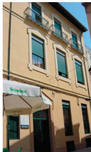
2-5. Composición y recercado de huecos. Revoco continuo.
