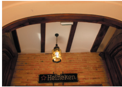
17. Viguetas de madera.
