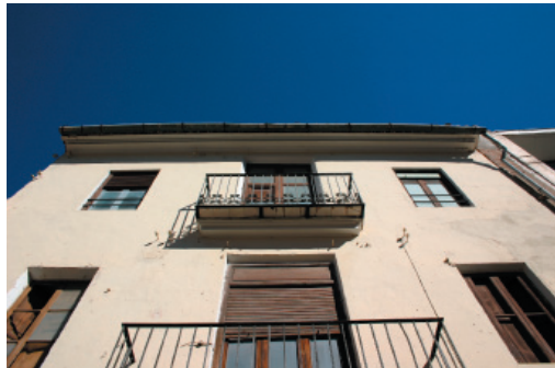
1-6. Alero y canalón de acero galvanizado.
