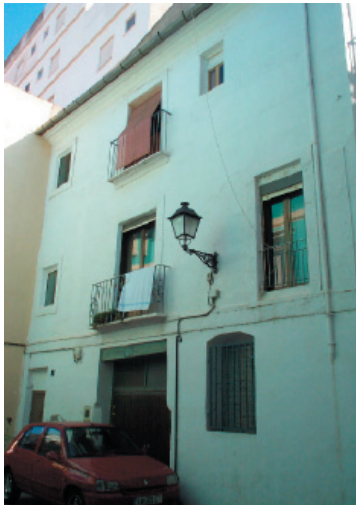
2-4-5. Fenestración y rejería. Revoco continuo pintado.
