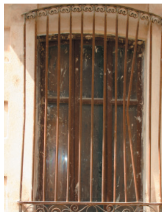
4-7-10. Carpinterías de madera. Rejerías de forja. Alfeizar de piedra.
