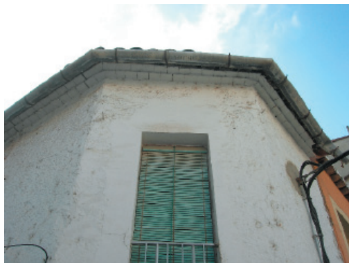
1-6. Alero y canalón de acero galvanizado.
