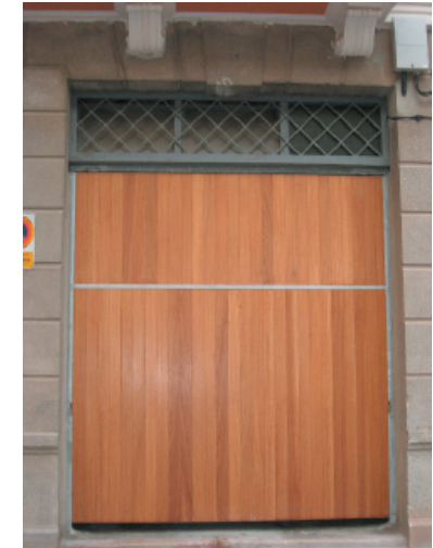
5. Carpintería de aluminio en la puertadel garaje.
