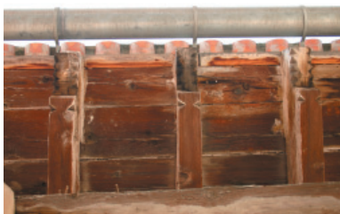
1-6. Alero y canalón.
