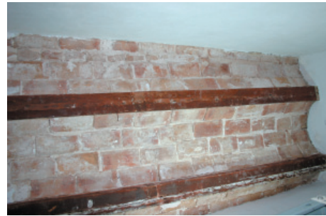
17. Viguetas de madera y revoltón de ladrillo
