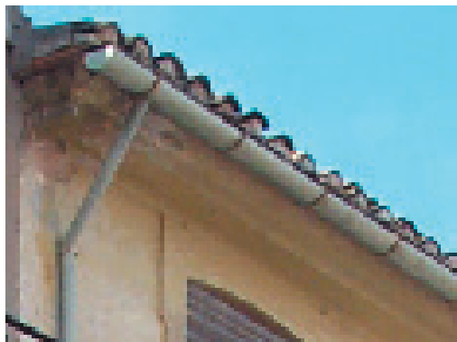
1-6. Alero y canalón de acero galvanizado.
