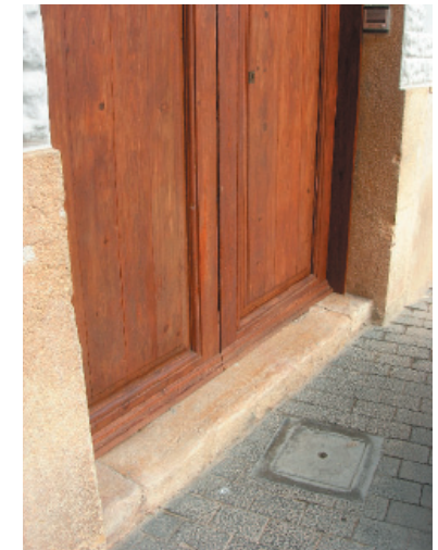
3-7. Carpintería de madera. Remate de piedra natural.
