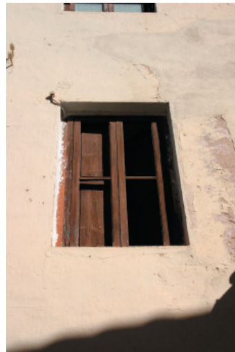
2-3-5. Fenestración, carpintería. revoco contínuo pintado.
