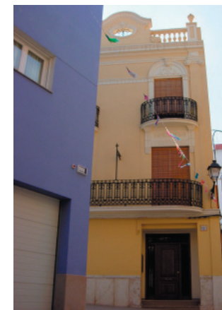
13. Balaustrada en el antepecho de la fachada principal.
