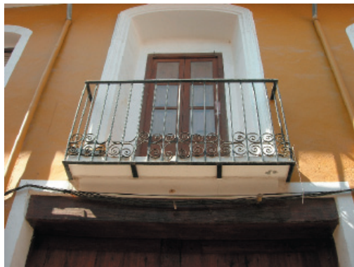
2-4-5. Fenestración y rejería de hierro pintado. Revoco continuo pintado.
