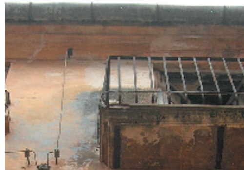
1-6. Alero y canalón de acero galvanizado.
