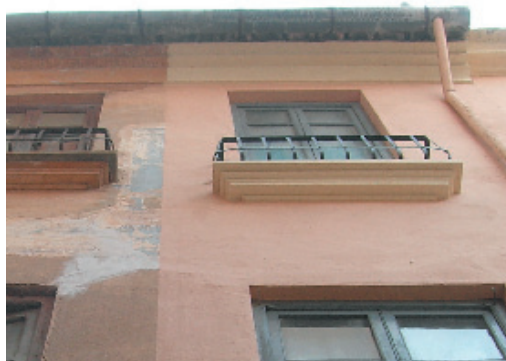
1-6. Alero y canalón de acero galvanizado.
