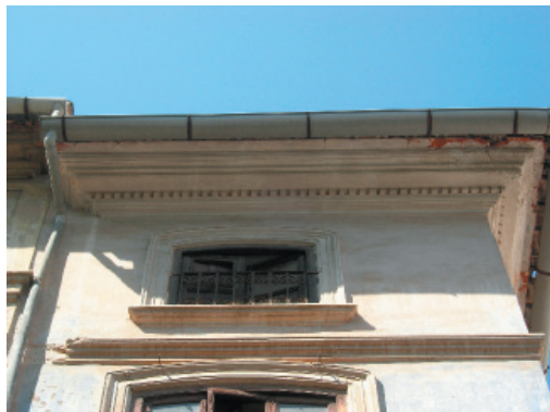
1-6. Alero y canalón de acero galvanizado.
