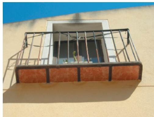
4-5-7. Rejería de hierro pintado, mortero monocapa. Sotabalcó de azulejo cerámico.
