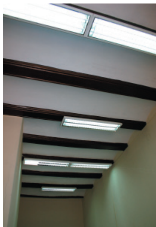
13. Viguetas de madera
