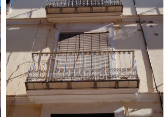
2-3-4. Fenestración y carpintería. Rejería de hierro pintado.
