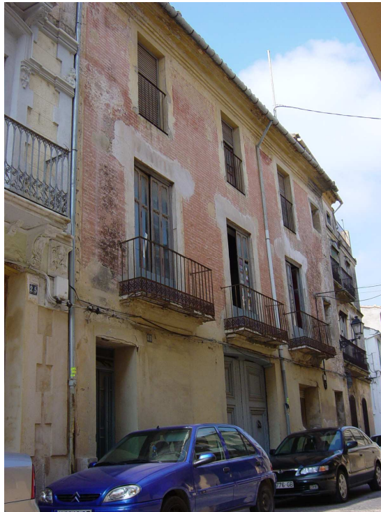
M5/17. Tipología de edificación señorial. Nuevo elemento protegido por el Catálogo de Bienes y Espacios Protegidos d'Alzira.
