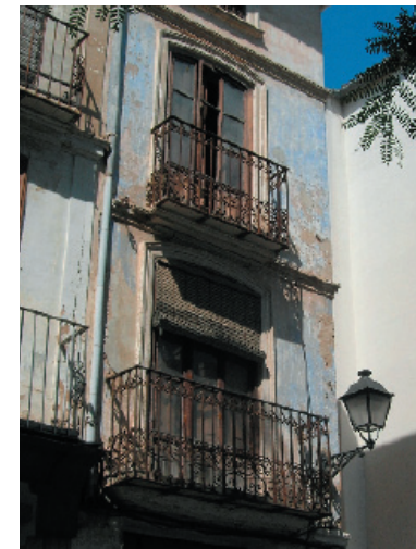
2-5. Fenestración y revoco.
