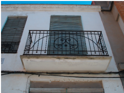
1-2-5. Alero, fenestración y rejería.
