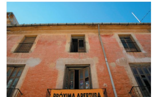
1-6. Alero y canalón de acero galvanizado.
