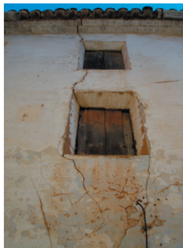
2-3-5. Fenestración y carpintería.
