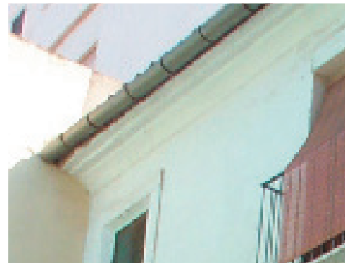
1-6. Alero y canalón de acero galvanizado.
