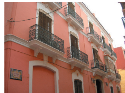
2. Correspondencia vertical de huecos. 3-6-7. Recercado de huecos. Protectores de persianas de madera. Rejería de forja.
