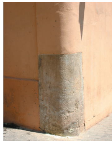
9. Remate en esquina de piedra
