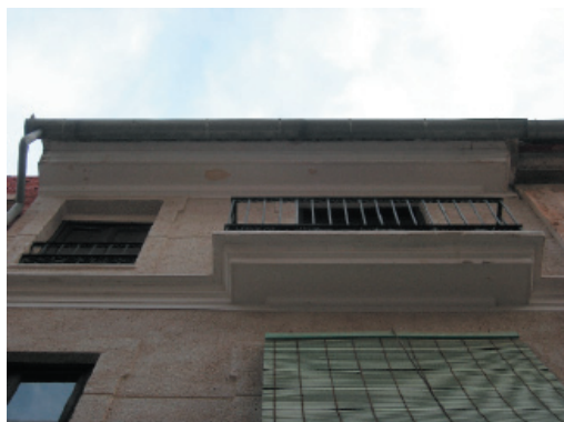
1-7. Alero y canalón.
