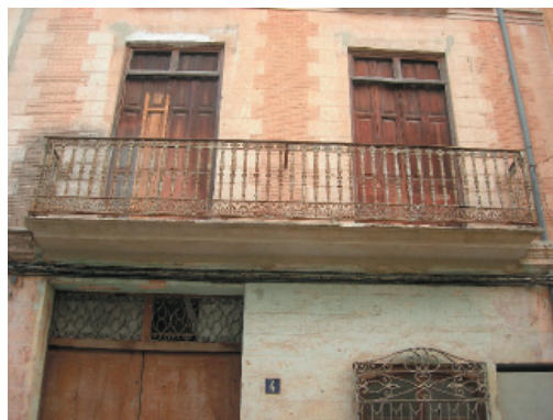
2-3. Fenestración y carpintería de madera.
