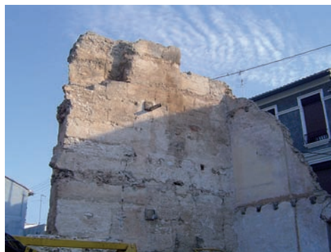
Imatge 26a Mur per la banda oest MUMA
