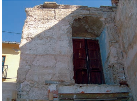
Imatge 30b Treballs previs mur nord, interior. MUMA
