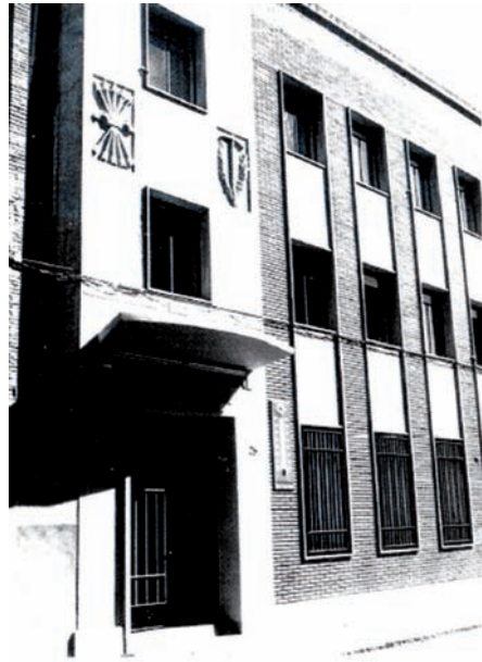
Edifici-seu del Sindicat Vertical. (Alzira. Crònica del siglo XX. (1956-1970), A. Lairón, p. 74.
