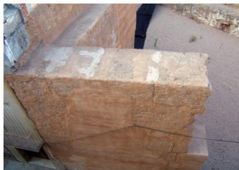
Imatge 30d Coronació mur nord MUMA
