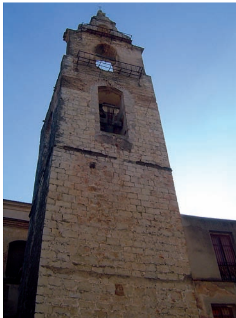
Imatge 48a Torre campanar, cara oest MUMA
