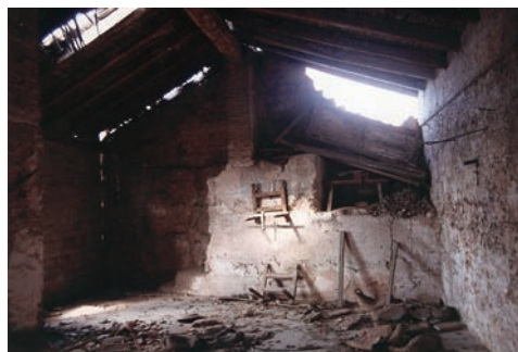
Imatge 25b Detall del mur d'encofrat en l'andana MUMA
