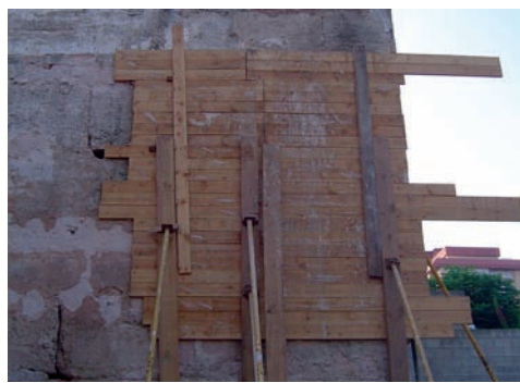
Imatge 30c Consolidació mur nord, exterior. MUMA
