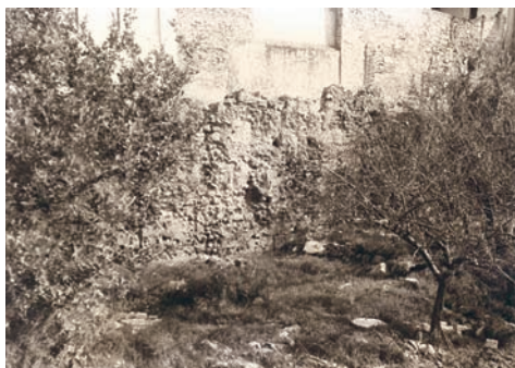
Imatge 11a. Detall encofrats. MUMA
