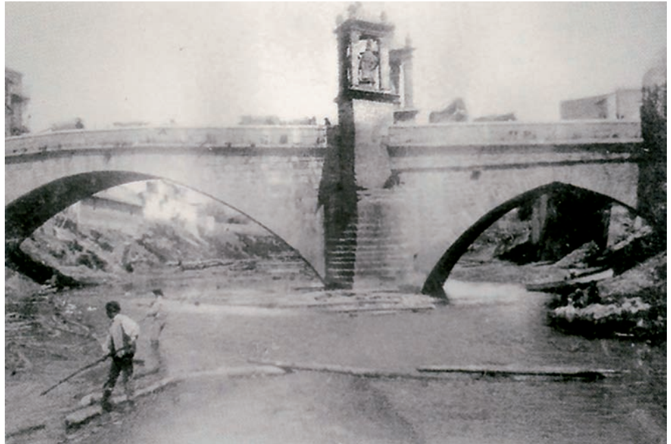
Conducció de fusta al riu Xúquer, junt al pont de Sant Bernat d'Alzira (imatge extreta de Piqueras, 2015)
