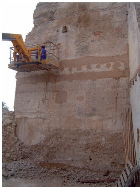
Imatge 30a Consolidació mur oest MUMA
