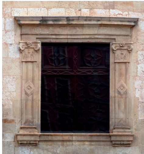
Finestral renaixentista, amb pilastres rematades per capitells compostos, del primer cos de la façana de la seu de l'Ajuntament d'Alzira, edifici bastit poques dècades després de l'episodi de les Germanies (foto TP)
