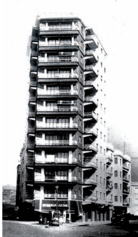
Edifici "La Torre". En l'inici del desenvolupament urbanístic de la ciutat. (Alzira. Crònica del siglo XX (1956-1970), A. Lairón, p. 138.
