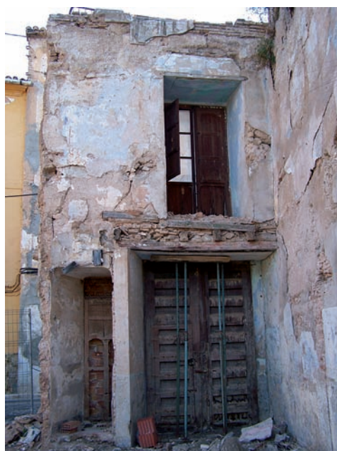
Imatge 26b Mur nord amb apertures de portes i finestra MUMA
