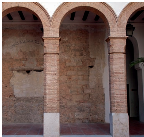
Imatge 56a Vista general del mur església S. Agustí MUMA
