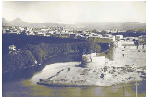
Imatge 19. Estat abans construcció Pont de Ferro. Anònim
