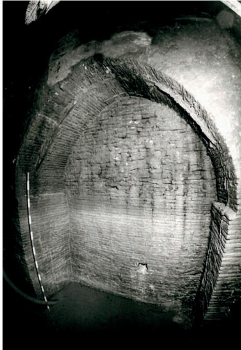
Imatge 50 Arc per a la captació d'aigua en la sènia. MUMA
